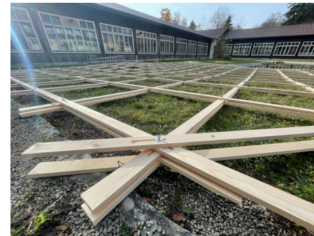
Holzlatten flach ausgelegt
