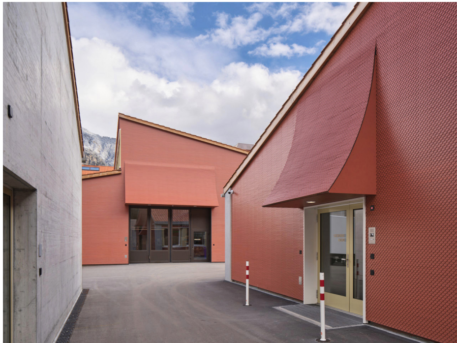
JVA Cazis Tignež, Nebengebäude, Foto Ralph Feiner
